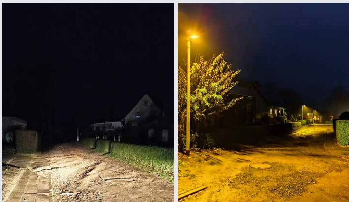
Beleuchtung vor und nach der Installation
